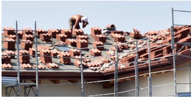
Operaio edile mentre lavora alla costruzione di un tetto
