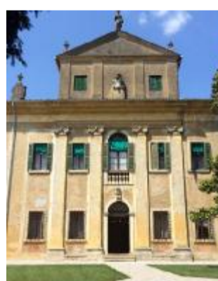
La facciata di villa Guastaverza
