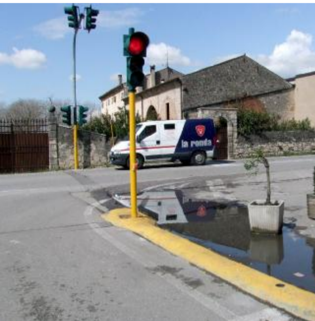
Il semaforo all'incrocio di Decima, lungo la strada provinciale 10
