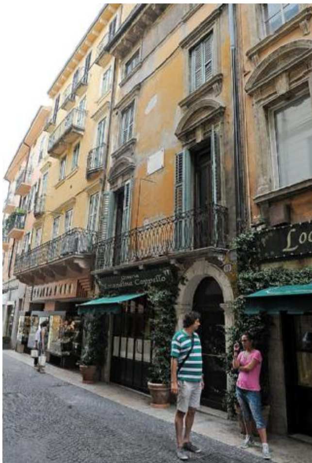
Paura in via Cappello per un'infiltrazione d'acqua DIENNE FOTO
