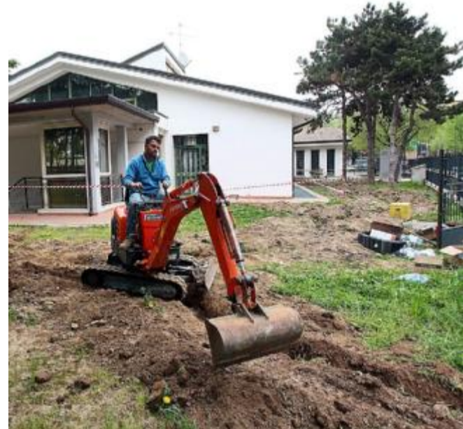
Ruspe e scavi nel Centro d'incontro di via Brunelleschi FOTO MARCHIORI
