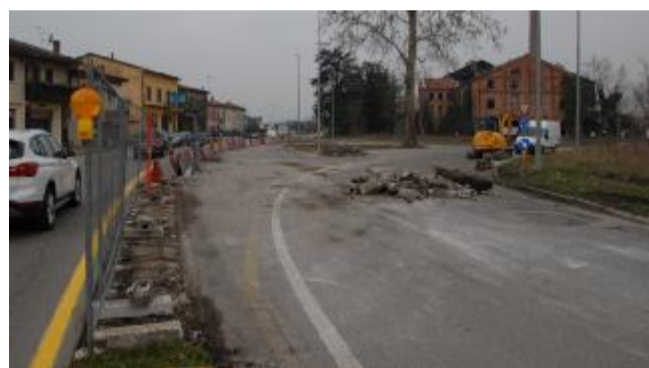
I primi interventi per la realizzazione della rotatoria
